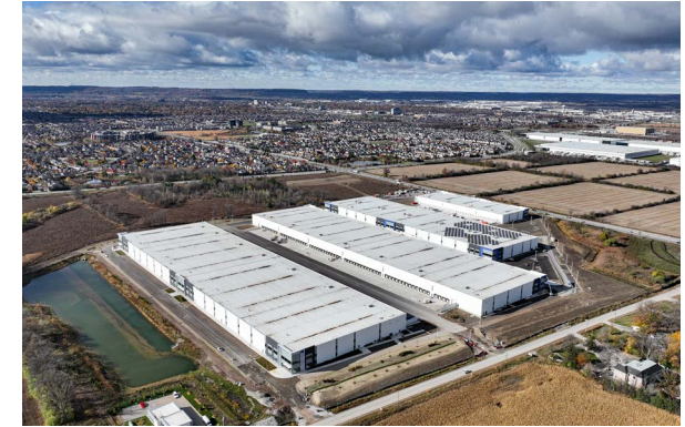
Bâtiment entièrement électrique à zéro émission nette de carbone en Ontario
